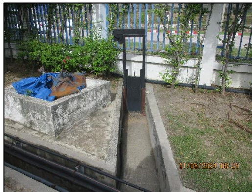
ภาพที่ 2.16 ประตูกันรางระบายน้ำฝนในพื้นที่โครงการฯ
