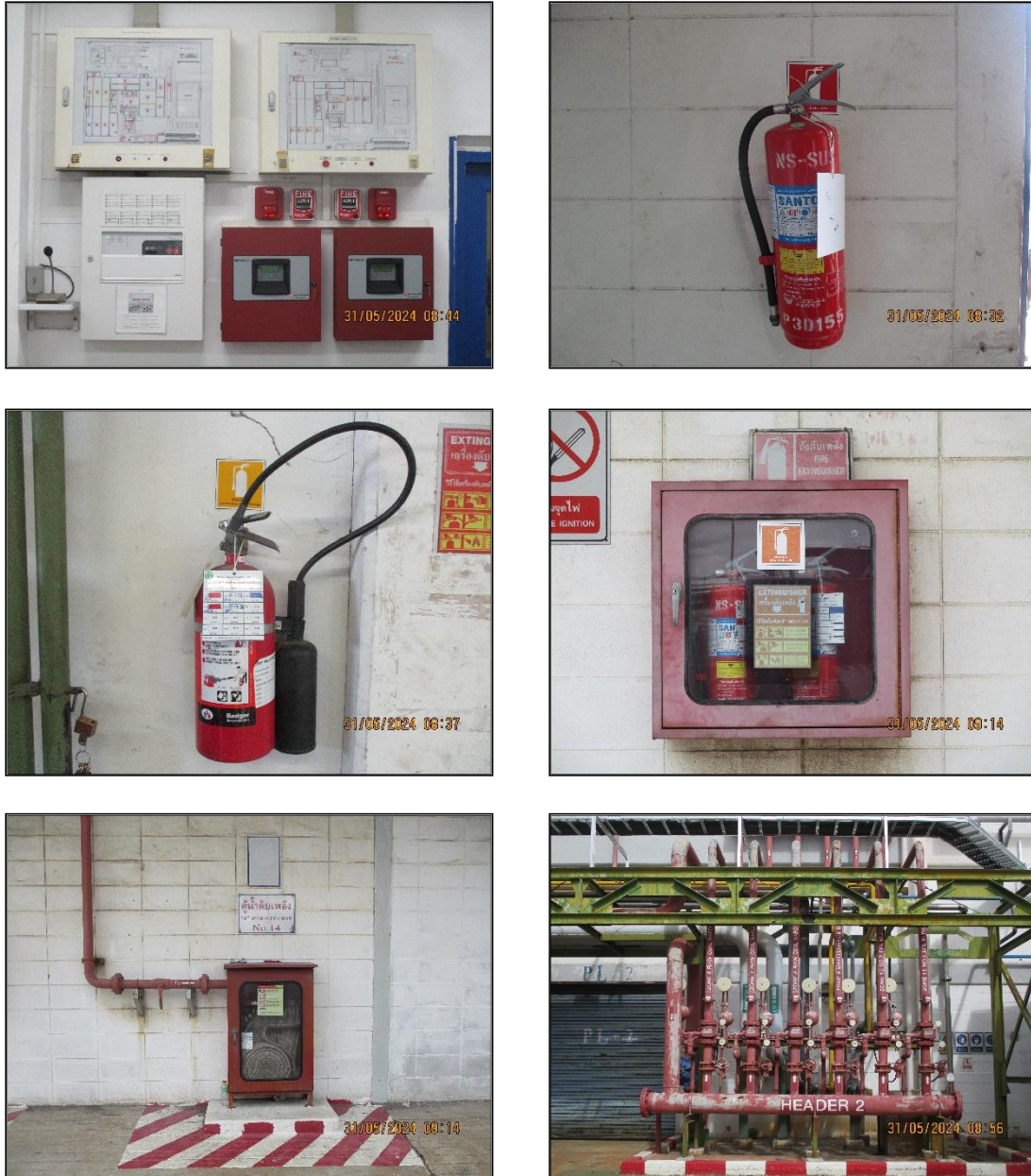
ภาพที่ 2.19 สัญญาณเตือนภัยและระบบดับเพลิงในพื้นที่โครงการฯ
